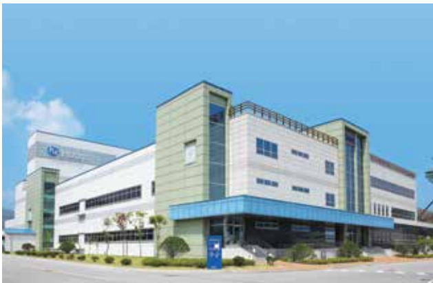
Huons Jecheon Plant 1
